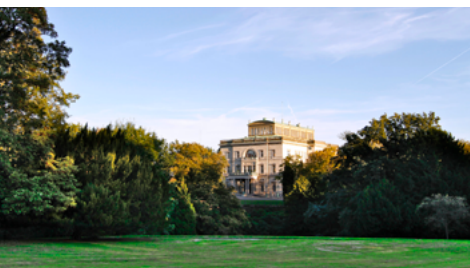
Villa Hügel, Blick auf die Nordseite
